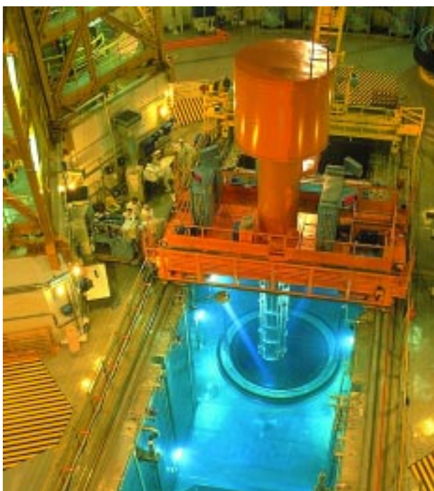
Centrale de Chooz B chargement du réacteur La médiathèque EDF/Pierre Bérenger
