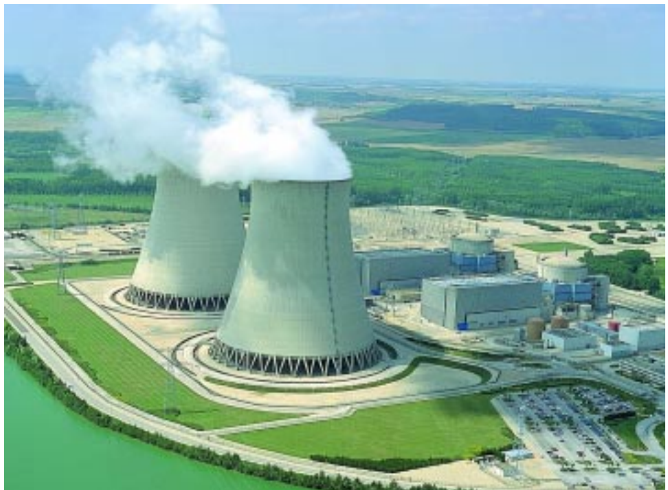
Vue aérienne de la centrale de Nogent sur Seine La médiathèque EDF/Gérard Halary
