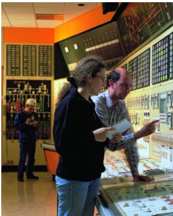
Arrêt de tranche à la centrale de Dampierre en Burly (Loiret) Salle de commande
