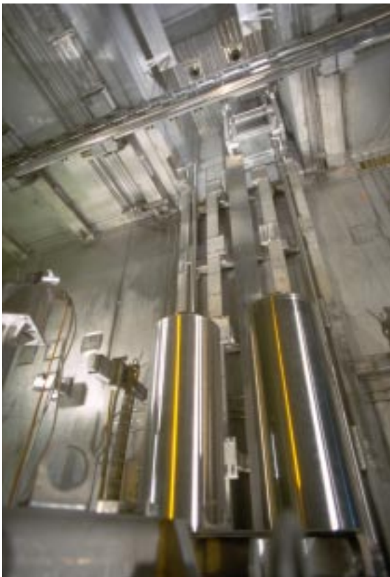
Cellule de coulée de l'atelier de vitrification Usine Cogema La Hague
