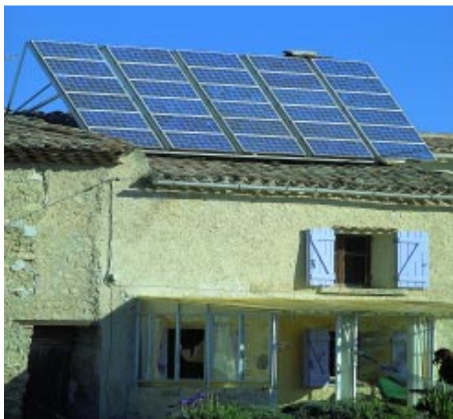
Panneaux photovoltaïques La médiathèque EDF/Stéphane Zaubitser
